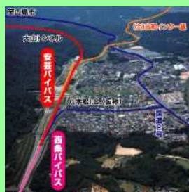
バイパスの整備
