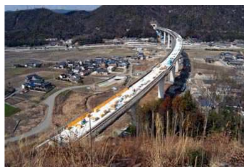
尾道JCT～三刀屋木次IC間(約111km)は、新直轄方式で整備中
