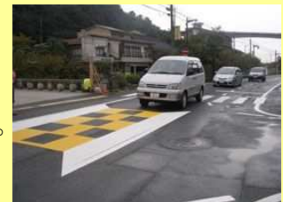
イメージハンプの設置状況
