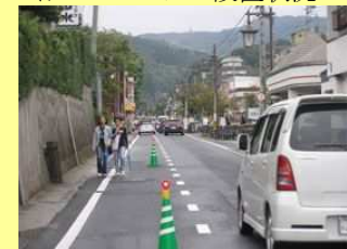
イメージ歩道の設置状況
