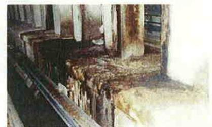
▲アスファルトラインにおける漏水腐食進行
