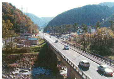
▲都市間を連携する生活幹線道路ネットワーク (一般国道179号 奥津上齋原バイパス)
