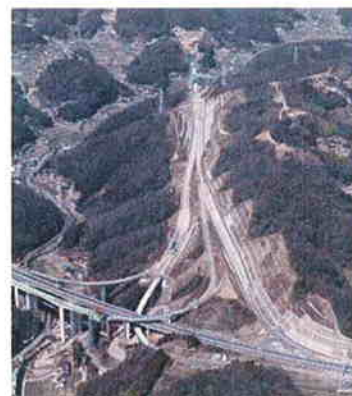
▲高規格幹線道路の整備 (中国横断自動車道 尾道松江線)
