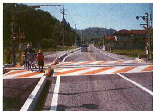
▲踏切内における歩道の設置
