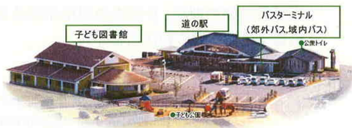
▲様々な機能と交通結節点を集約した道の駅「クロスロードみつぎ」
