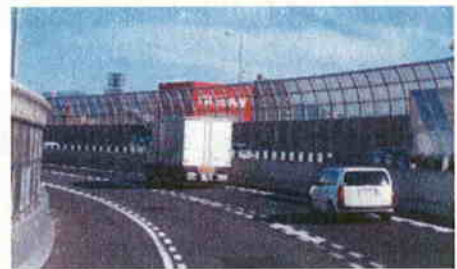
▲バイパスにおける遮音壁の設置
