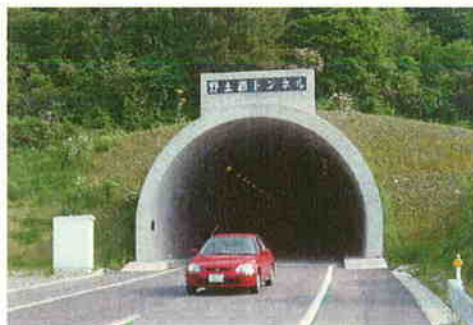
▲交流ふれあいトンネルの整備 ((主)北房川上線 野土路トンネル)
