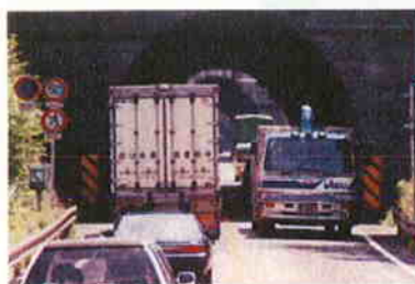
▲国際コンテナ通行支障トンネル (清水トンネル)
