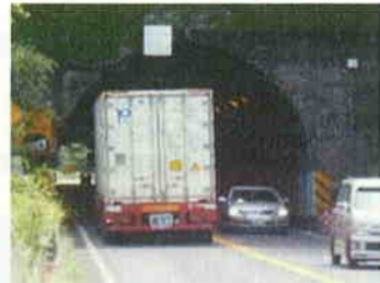
国際コンテナ通行支障トンネル（6箇所）の存在
