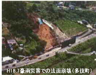
H18.7豪雨災害での法面崩壊（多伎町）
