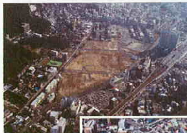
二葉の里地区再開発計画 (写真は現況)
