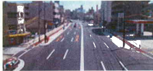
国道54号における低騒音舗装の整備
