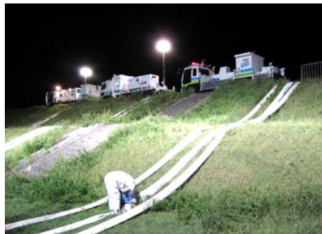
排水ポンプ車による緊急排水 (福知山市弘法川)
