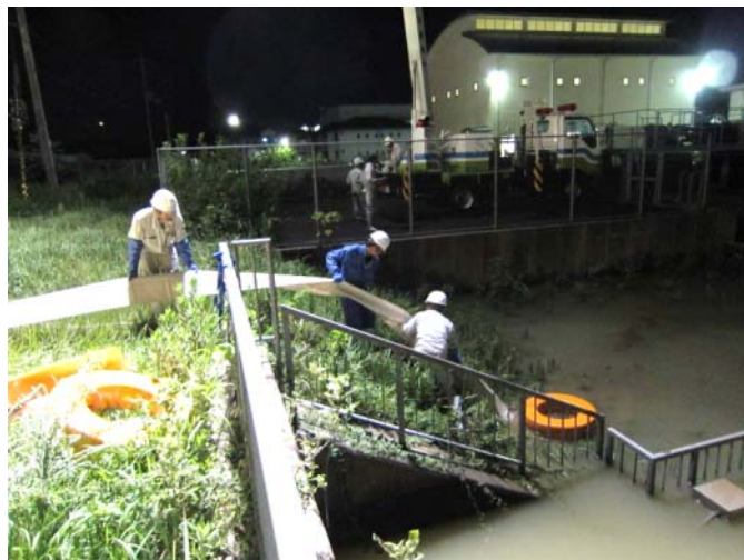
排水ポンプ車設置開始(20:30)
