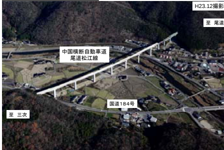
写真① 甲奴IC～吉舎IC間(海田原高架橋)
