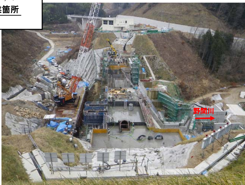
ダム本体(H24年3月撮影)
