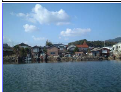
湖岸堤整備前（松江市本庄地区）
