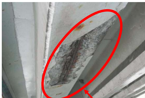
剥離・鉄筋露出
