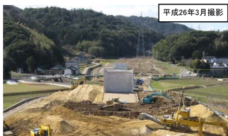
写真①江谷川橋を西方向に望む (橋の脚を造っています)
