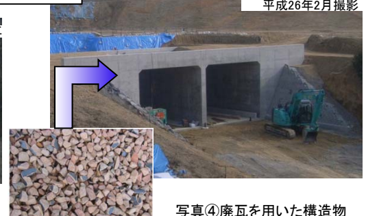
写真④廃瓦を用いた構造物 (廃瓦をコンクリートの材料として利用します)
