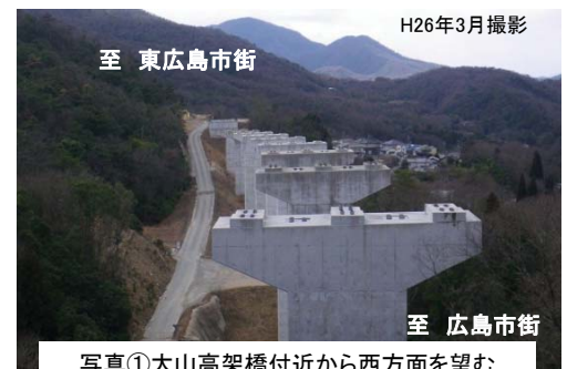
写真①大山高架橋付近から西方面を望む (下部工事が完了し、今後橋をかけていきます)
