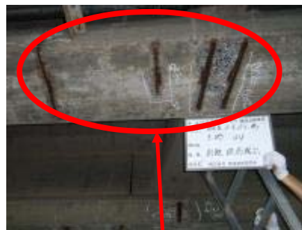
剥離・鉄筋露出
