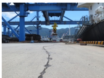
老朽化しエプロンに亀裂が生じた岸壁
