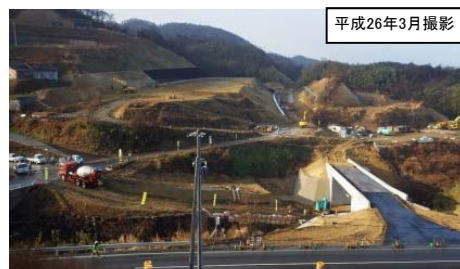
写真③多伎IC(仮称)を西方向に望む (道路の高さまで山を切っています)
