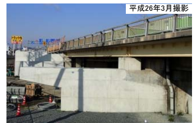
写真②大樋橋拡幅工事の施工状況 (道路広げるために橋の脚を広げています)
