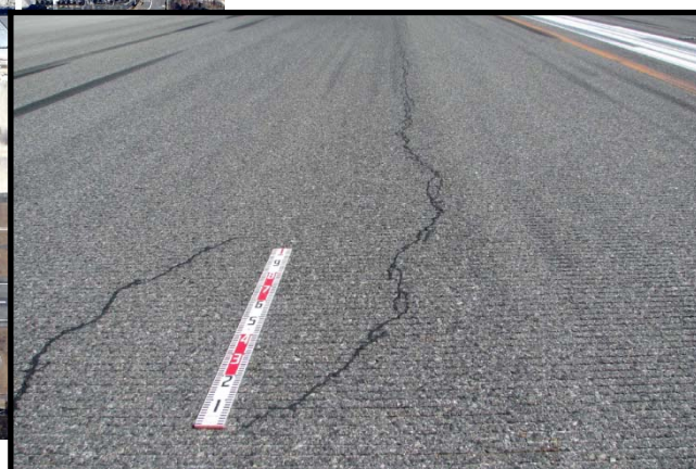
舗装表面の経年劣化によるひび割れの発生
