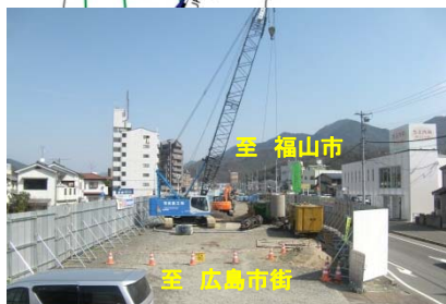
写真③海田高架橋施工状況 (橋を造っています)
