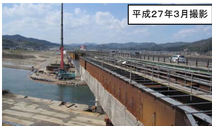
写真①里熊大橋を広島方向に望む (橋を架けています)
