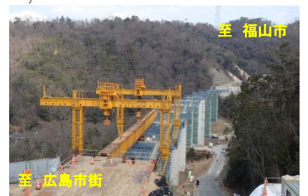
写真①大山高架橋施工状況 (橋を架けています)
