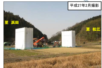
写真③東神西高架橋を松江方向に望む (橋を造っています)
