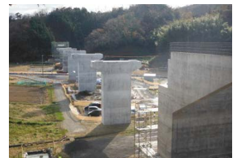
写真① 福井地区 (橋を造っています)
