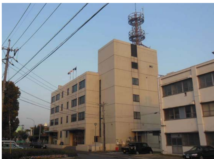
水島港湾合同庁舎2号館現況外観
