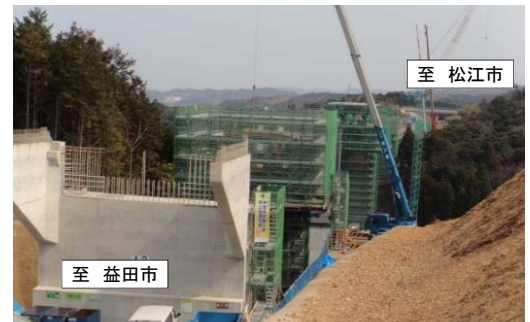
【写真②】西村地区施工状況(橋を造っています)
