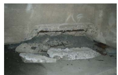
【損傷状況】コンクリート落下
