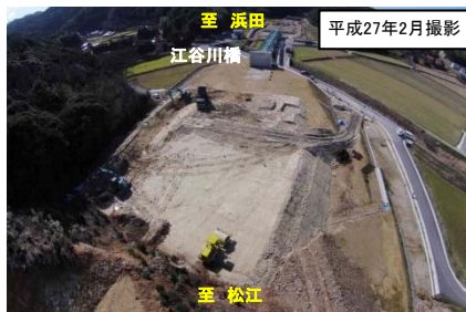
写真①江谷川橋東側を浜田方向に望む (道路の高さまで山を切り、土を盛っています)
