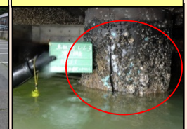
鋼管杭の老朽化
