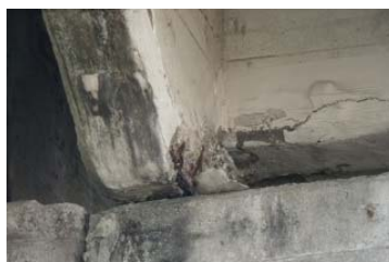
【損傷状況】橋本体のひび割れ
