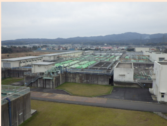
【島根県宍道湖東部浄化センター全景】
