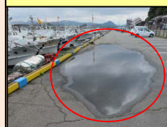
エプロン部の陥没
