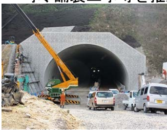
写真①「道竹城トンネル」(H27.2撮影)
