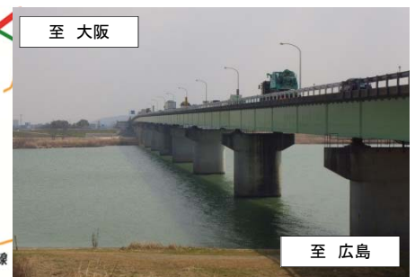
【写真①】高梁川大橋施工予定箇所
