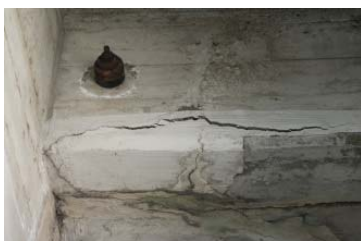
【損傷状況】橋本体のひび割れ
