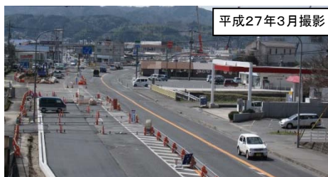
写真②里方地区を広島方向に望む (道路を広げる工事をしています)
