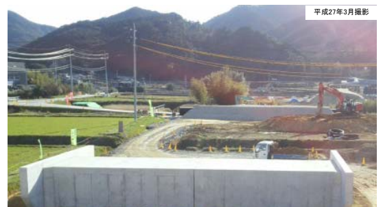
写真② 深川湯本地区施工状況 (道路の高さまで土を盛っています)
