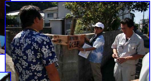
通り名標示板設置の様子
