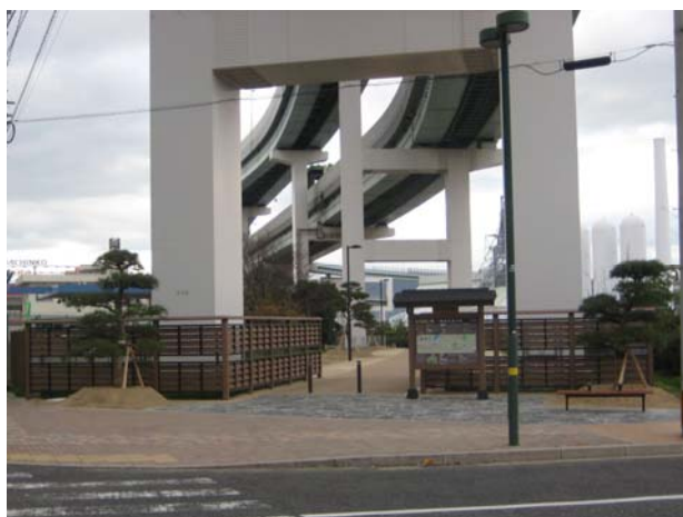
完成した東田遊歩道
