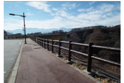
防護柵塗り替え後
