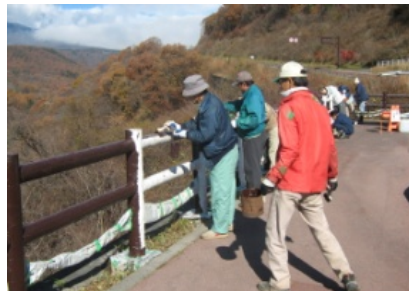
防護柵塗り替え中
