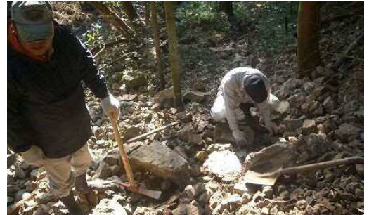
多田溪谷の土砂崩れの修復作業
