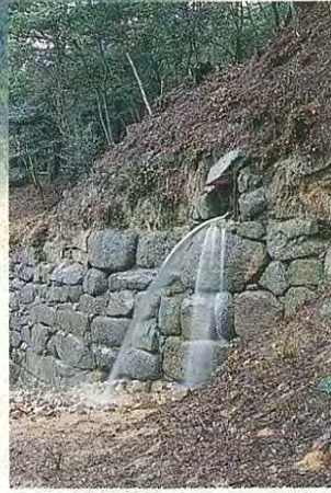
谷に築かれた水門
