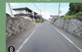
宿場町に洪水が流入するのを防ぐた めの貴重な土木遺産です。
