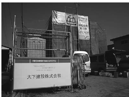
「ファース工法」を用いた「ファースの家」の新築工事現場
