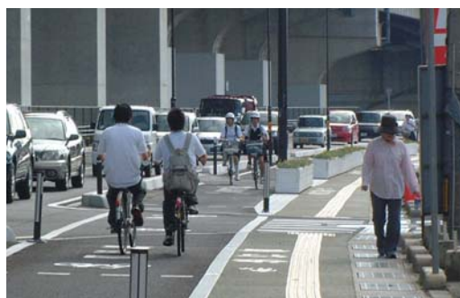
▲自転車道の設置
