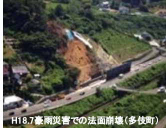
H18.7豪雨災害での法面崩壊(多伎町)
