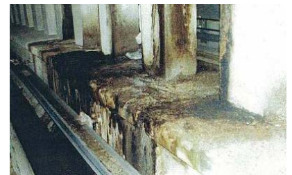
▲アストラムラインにおける漏水腐食進行
