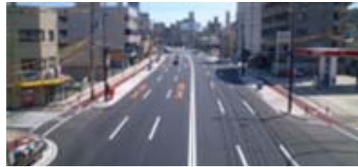
国道54号における低騒音舗装の整備
