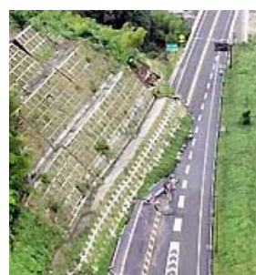
▲豪雨による道路被害 (山陰道 H18.7)
