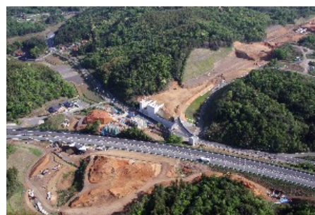
▲道路ネットワークの整備 (地域高規格道路 小郡萩道路)
