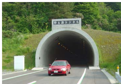
▲ 交流ふれあいトンネルの整備 ((主)北房川上線 野土路トンネル)
