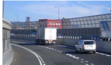
▲バイパスにおける遮音壁の設置
