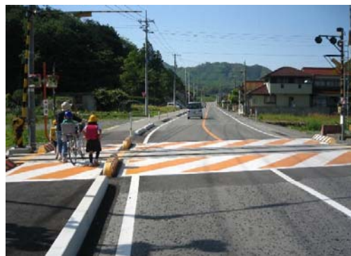
▲踏切内における歩道の設置
