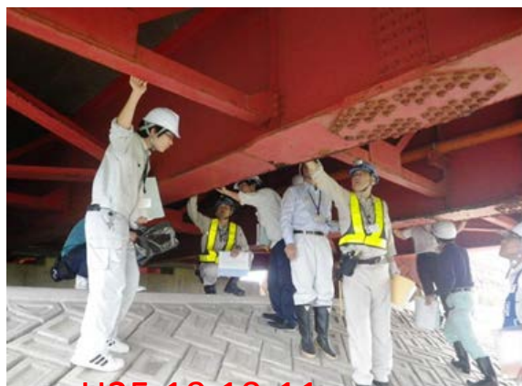
H25.10.10-11 点検講習会の様子
