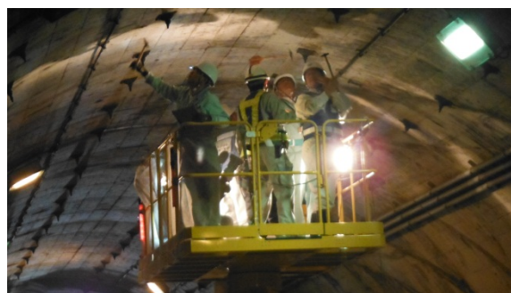
H25.10.29 点検講習会の様子
