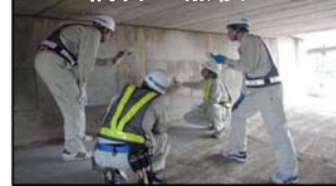
床版のひび割れ
