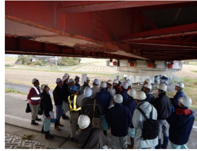
現地実習(鋼橋の損傷状況)
