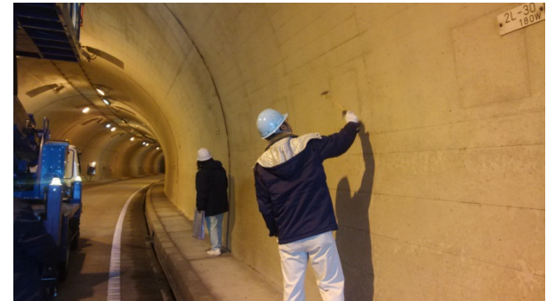
現地状況確認(トンネル側壁部)
