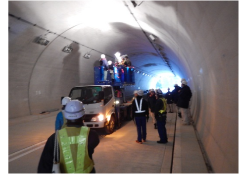
現地状況確認(トンネル側壁部)
