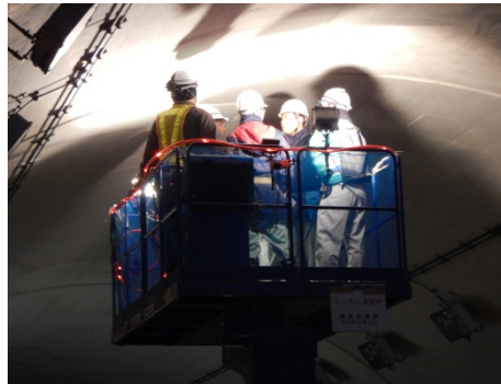
現地状況確認(トンネル頂部)
