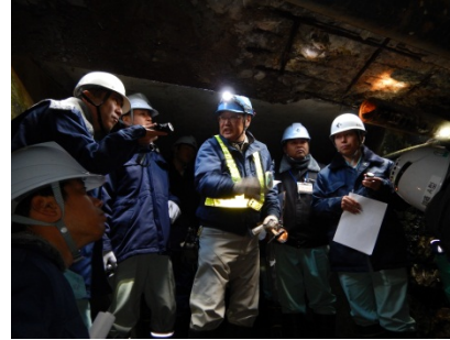
現地実習(損傷状況の確認)
