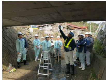
現地実習(損傷状況の確認)
