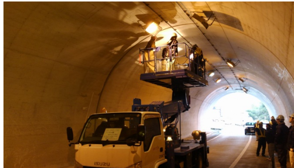
現地状況確認(トンネル頂部)
