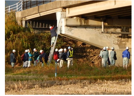
現地実習(橋脚の状況)
