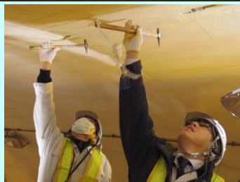
点検ハンマーによる打音点検
