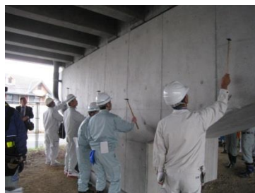
打音点検体験状況
