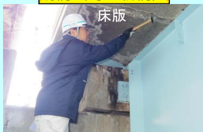
近接目視、打音検査
