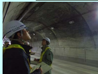
近接、遠望目視による点検
