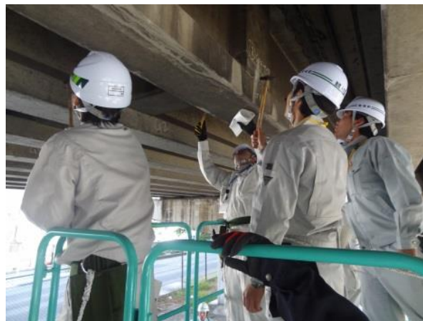
打音点検体験状況
