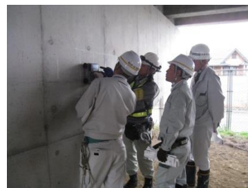
鉄筋探査状況
