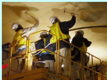
高所作業車による近接目視
