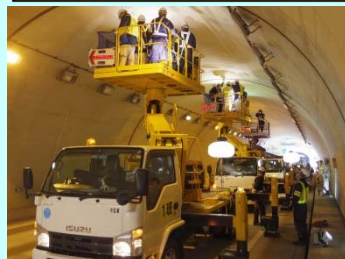
覆工上部を近接目視
