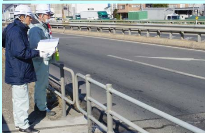
橋梁上面(伸縮装置)の異常の有無を確認
