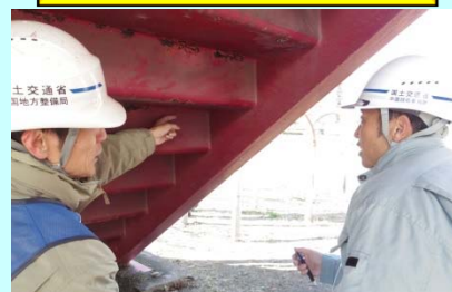
塗膜劣化状況の確認及び原因の追及
