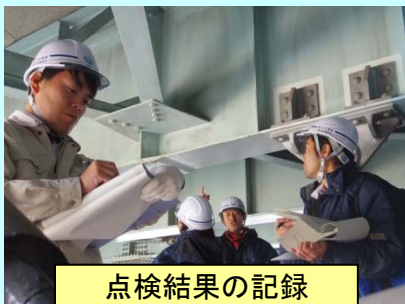
近接目視、打音検査
