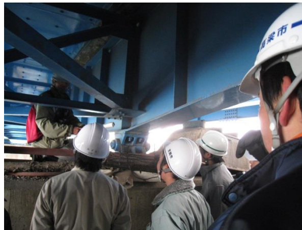
損傷状況確認状況
