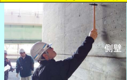
近接目視、打音検査
