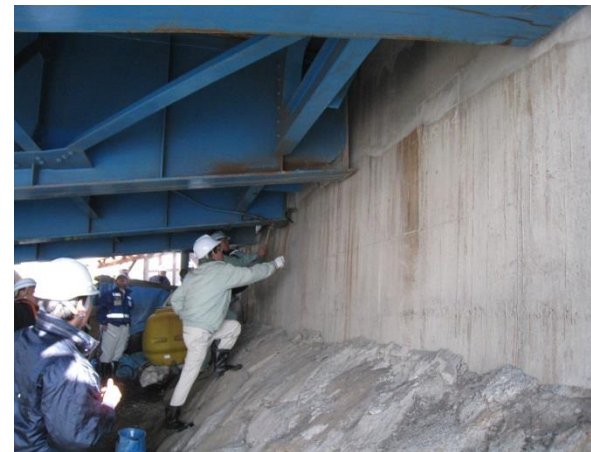
打音点検体験状況
