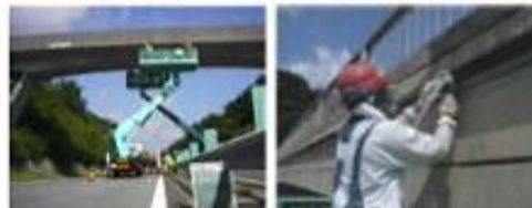
点検実施状況
