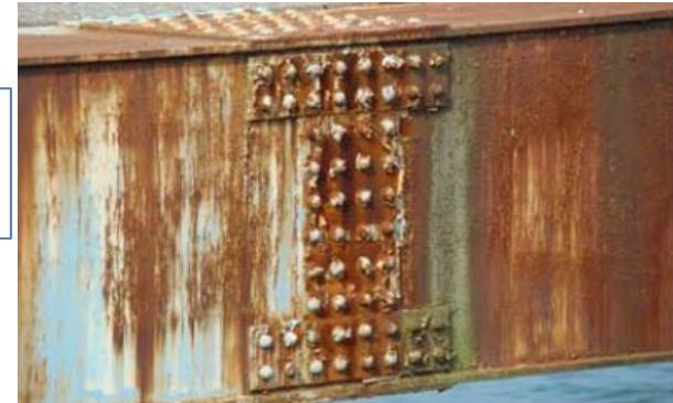
主部材に、広がりのある顕著な腐食が生じており、局部的に明確な板厚減少が確認でき、断面欠損に至ると構造安全性が損なわれる可能性がある場合
