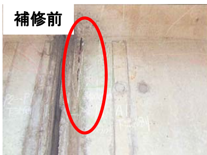
上部工の損傷 （鉄筋露出）
