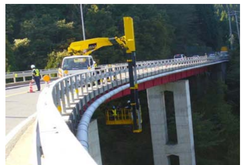
橋梁点検車による定期点検
