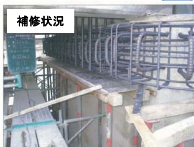
主桁橋座の補修
