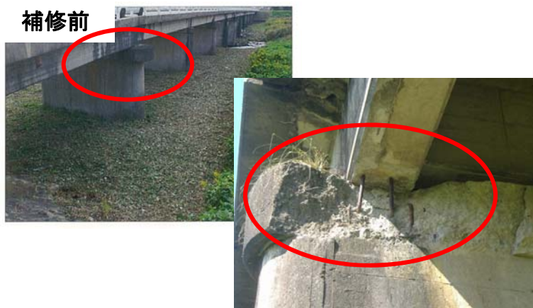
主桁橋座の損傷
