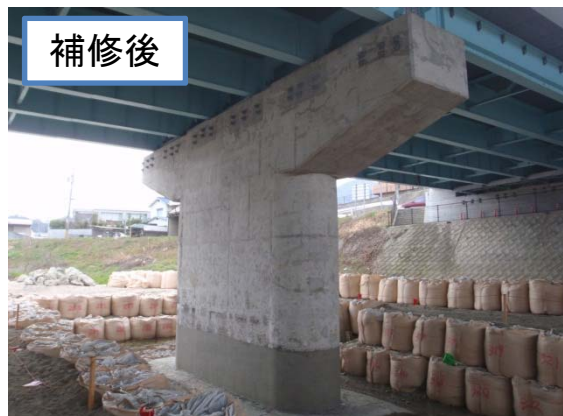
橋脚の補修（断面修復・ひびわれ注入・表面保護等）
