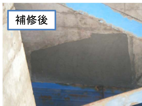
床版下面の補修 (断面修復)
