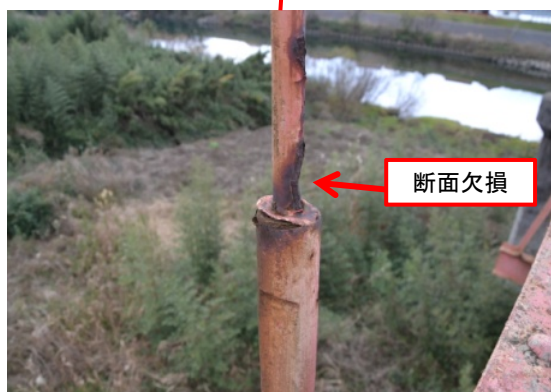
吊索の損傷
