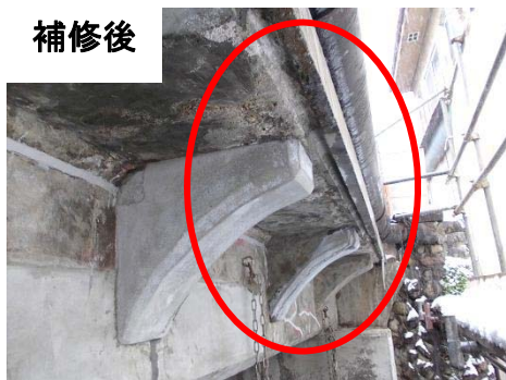
床版の補修 （断面修復工）
