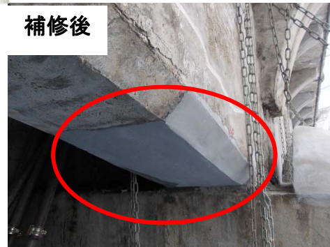
主桁の補修 （断面修復工）
