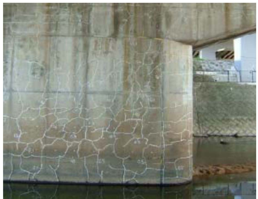
アルカリ骨材反応によるひびわれ
