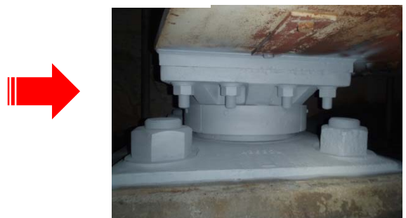
金属溶着による防錆処理
