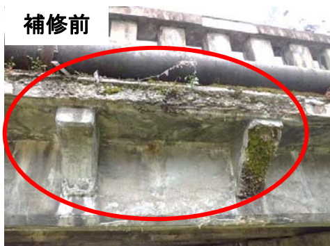
床版の損傷 （スケーリング・欠損）
