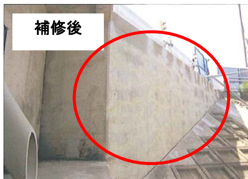
橋台の補修 （ひびわれ注入工）
