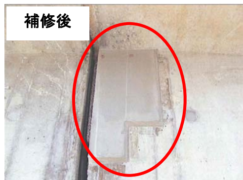
上部工の補修 （断面修復工）
