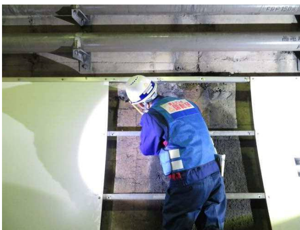
▲ 内装板背面の覆工の状態を確認 (道路メンテナンス技術集団)
