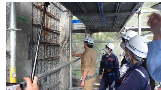
現場見学 (R2橋梁管理実務者Ⅱ研修)
