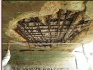
内部の鉄筋が露出した橋梁
