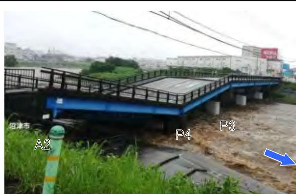
P4橋脚の沈下・傾斜
