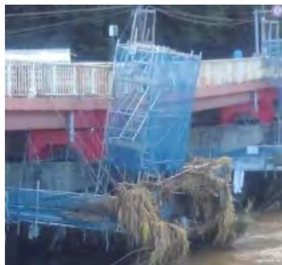
P2橋脚の沈下・傾斜
