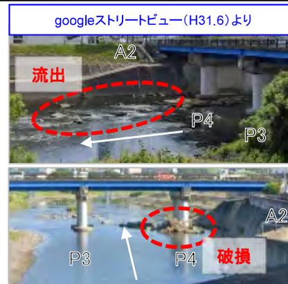
護床工の破損・流出(定期点検前)
