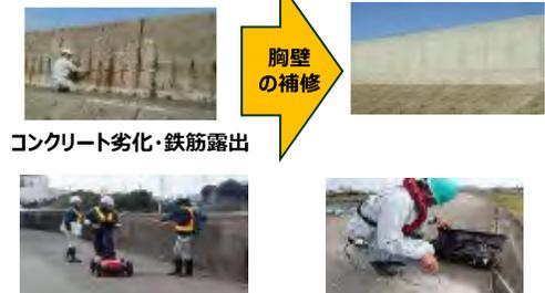
コンクリート劣化・鉄筋露出
