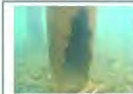
▲パイルベントの断面欠損
