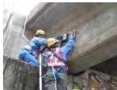
磁気磁束密度を測定し内部の損傷を把握
