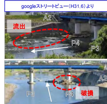
護床工の破損・流出(定期点検前)
