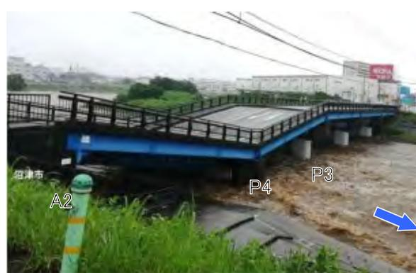
P4橋脚の沈下・傾斜
