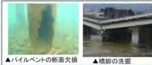
▲パイルベントの断面欠損 ▲橋脚の洗掘
