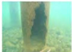
▲パイルベントの断面欠損
