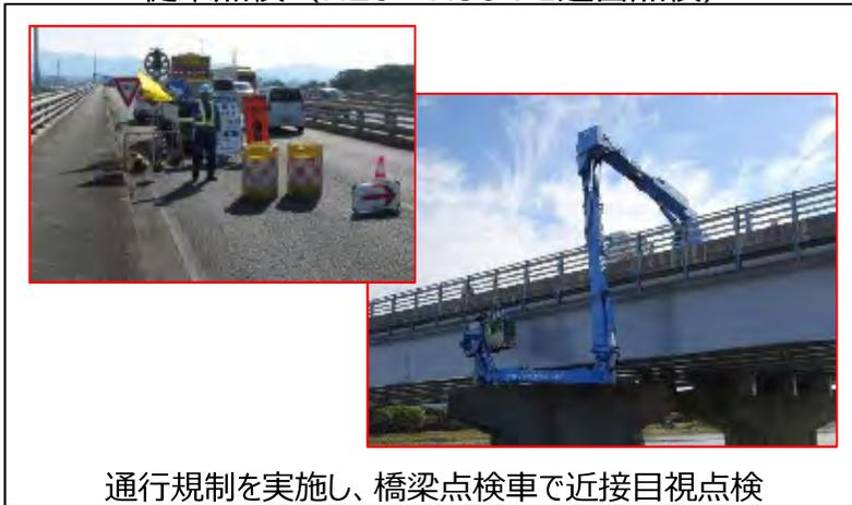
通行規制を実施し、橋梁点検車で近接目視点検
