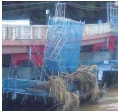
P2橋脚の沈下・傾斜
