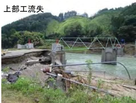
上部工流失(支承の損傷)
