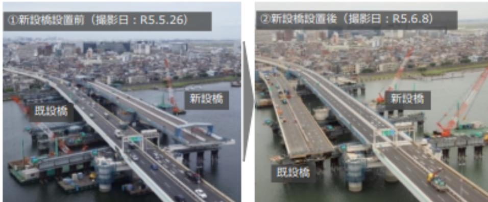
延長約300mの新設橋を既設橋の位置へ移動して架設
