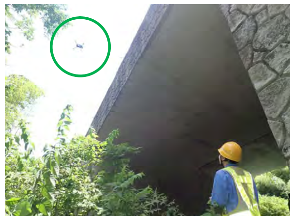
UAV 翼壁撮影 目視操縦
