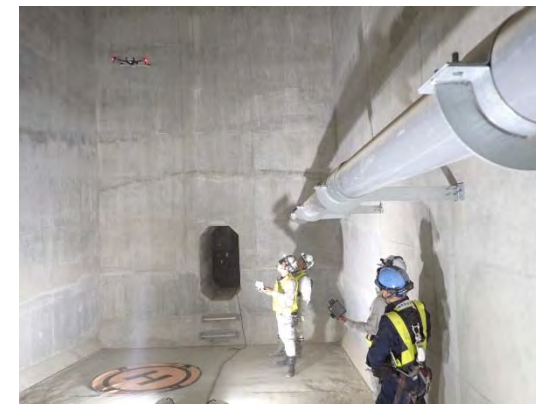
写真 新技術活用による点検状況
