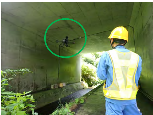
UAV 頂版撮影 目視操縦
