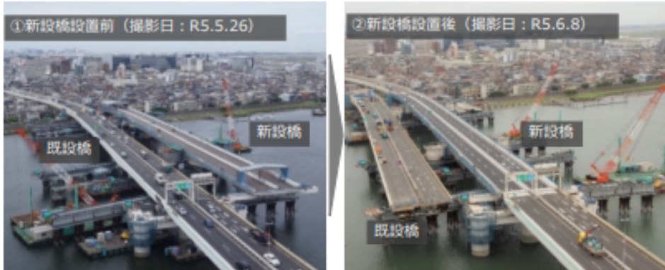
延長約300mの新設橋を既設橋の位置へ移動して架設 既設路線の通行止めから開通まで、2週間の短期間で実施
