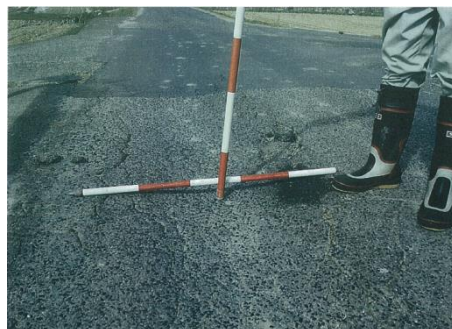
陥没時の路面状況（近影）
