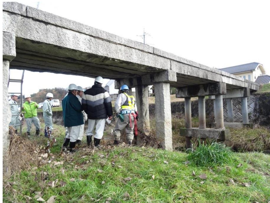
水流部のパイルベント2基施工。パイルベント間のつなぎ材を施工。
