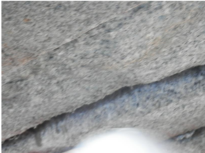
上部工近影：②の部位下面：部分的に石材が細くなっている状況。交通振動、自然風化等により、石材の節理部分から剥がれ落ちている状況と推定される。
