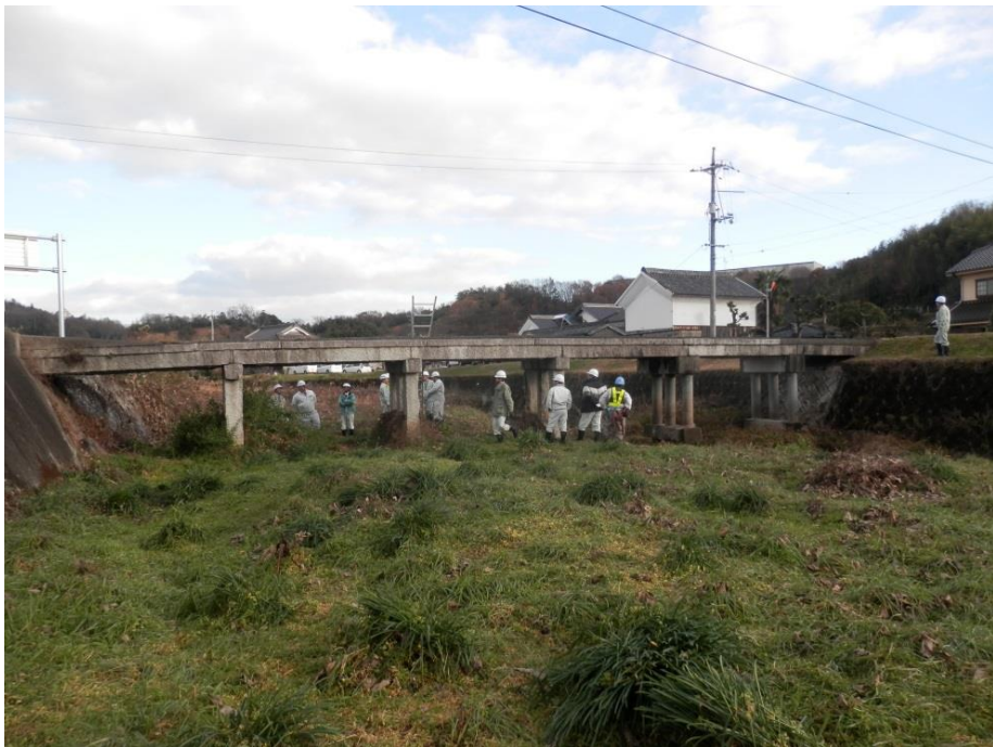
6径間の石橋(河川橋)。径間長は最大5m程度。
