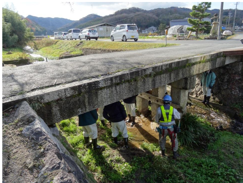
橋梁全景（上面）：舗装に目立った損傷は見られない。 すみ切り部に鋼板が設置されている。
