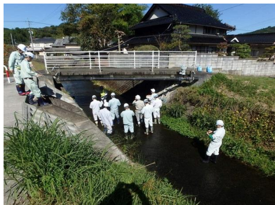
旧道橋(美咲町)
