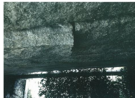
陥没時の上部工下面の状況
