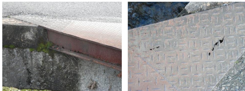
橋梁端部に設置された鋼板に孔食が見られる。孔食は、 天板及びウェブ部に発生しており、耐力力が低下している 可能性が高い。ウェブ部で孔食が発生している部位付 近には苔が繁茂しており、雨水が滞水している可能性が 高い
