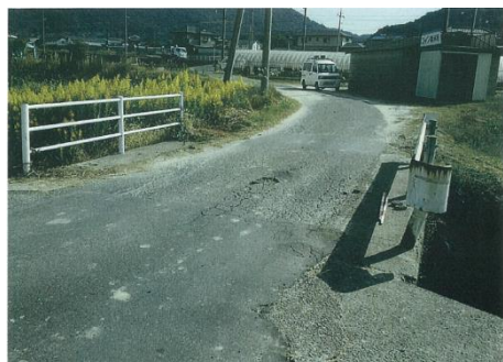
陥没時の路面状況（全景）
