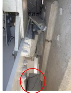
写真-6 支承の破壊の状況
