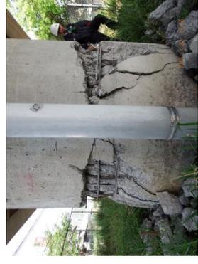
写真-7 段落し部の損傷
