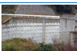
盛土 (補強土壁)
