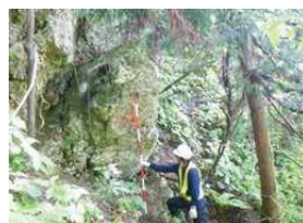
(危険度調査状況)
