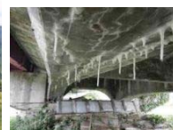
主桁のひびわれ
