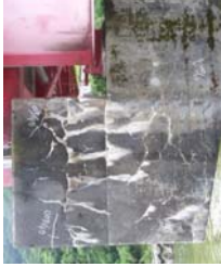
下部工にASRによる劣化が疑われる
