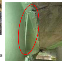
主桁の変形
