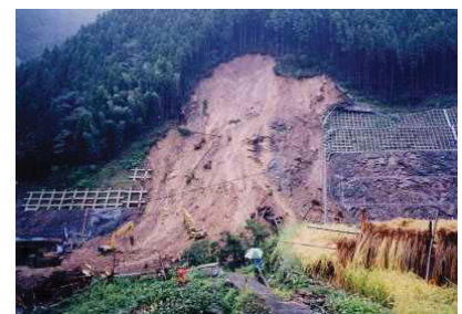
強風化・土砂化斜面での崩壊例
