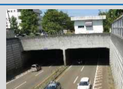
大型ボックスカルバート
