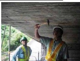
目視及びハンマーによる打音検査
