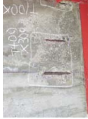
下部工にASRによる劣化が疑われる
