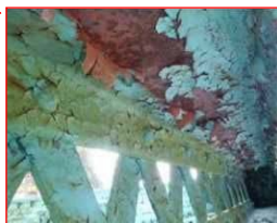
鋼材の腐食
