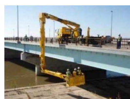
橋梁点検車による点検
