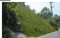
切土 (のり面保護)
