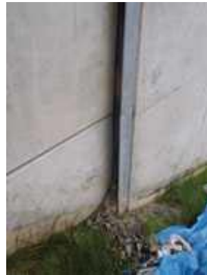
写真 土砂のこぼれ出し例
