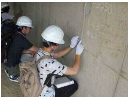
▲ ひび割れ調査を体験
