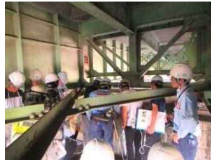
▲ ひび割れ調査を体験
