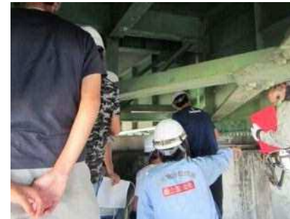
▲ 鋼材の腐食状況確認を体験
