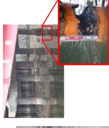
▲杭の水中部(腐食・断面欠損の例)
