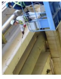
▲コンクリートのうき・はく離を非破壊で検査する技術
