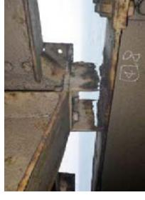
▲シエツド頂部の主梁端部(破断の例)
