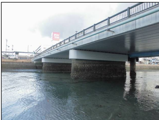
補修(架替)後 [PCプレテン中空床版橋]
