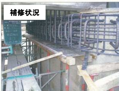
主桁橋座の補修 (鉄筋を組み直し、断面修復)
