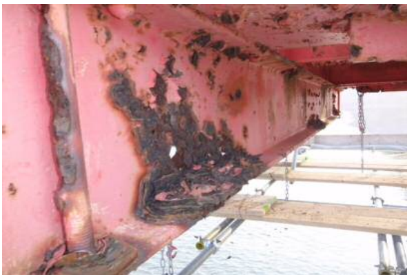
床組の損傷 (鋼部材の激しい腐食)
