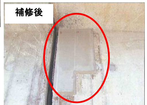
上部工の補修 (断面修復工)
