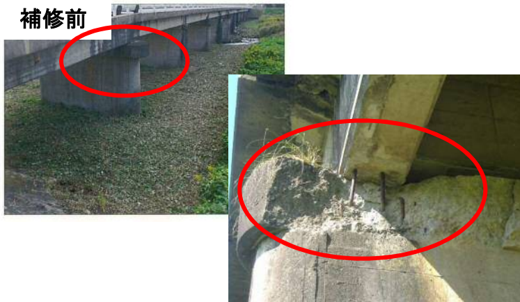
主桁橋座の損傷 (主桁の橋座が欠損し、腐食したアンカーバーが確認される)
