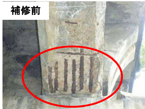
主桁の損傷 (下面の鉄筋が露出)
