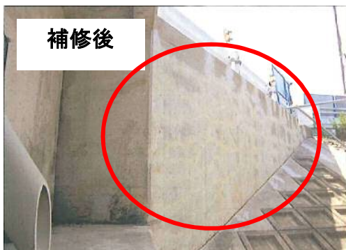
橋台の補修 (ひびわれ注入工)
