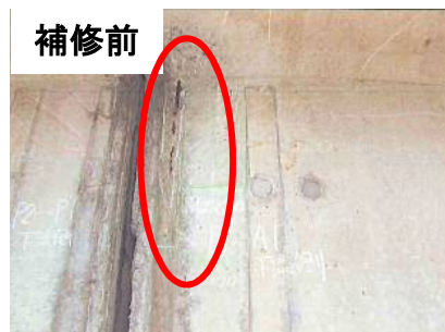
上部工の損傷 (鉄筋露出)
