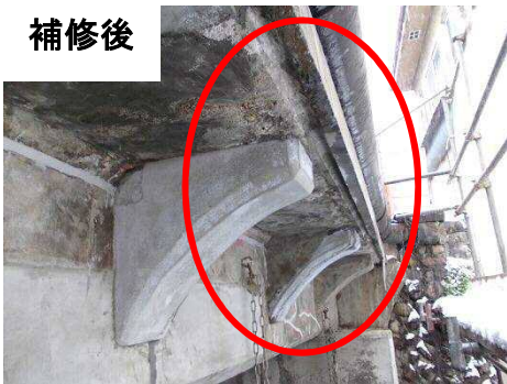
床版の補修 (断面修復工)
