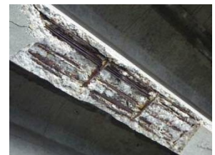
主桁の損傷 （ひび割れ・剥離・鉄筋露出）
