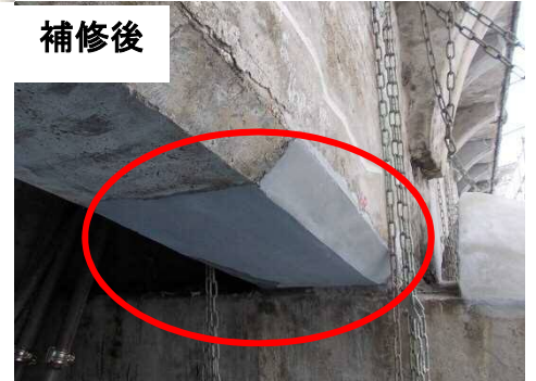
主桁の補修 (断面修復工)
