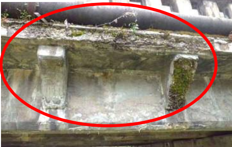
床版の損傷 (スケーリング・欠損)
