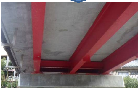
床版の補修（断面修復工） 主桁・支承の補修（塗り替え）
