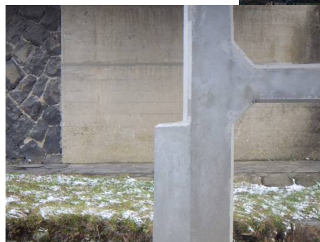
橋脚の補修（断面修復工）
