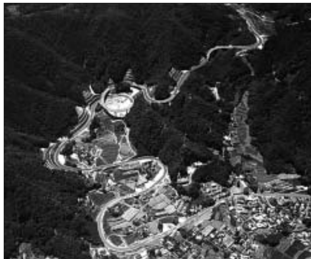
● 国道484号「上谷バイパス」
