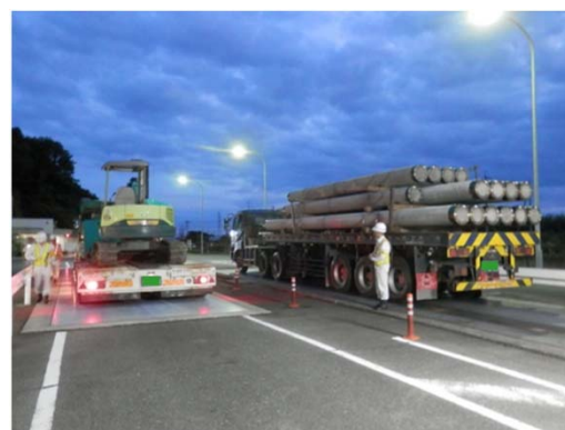
重量、寸法計測状況
