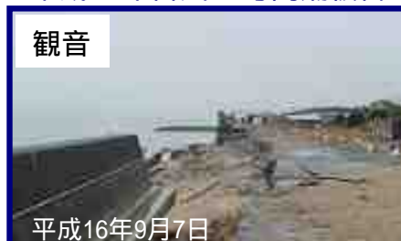
平成16年台風18号高潮被害
