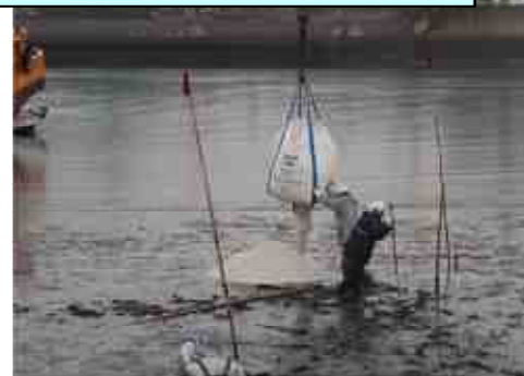
人力により、カキ殻を均一に敷き詰めた後、 深さ約20cmまで鋤き込みを実施
