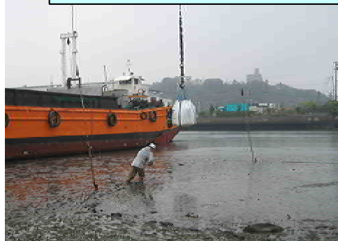
人力により、カキ殻を均一に敷き詰めた後、 深さ約20cmまで鋤き込みを実施
