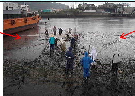
人力により、カキ殻を均一に敷き詰めた後、 深さ約20cmまで鋤き込みを実施
