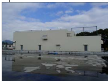
江波地区 雨水滞水池(完成予定)
