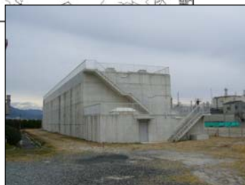
大竹処理区 雨水滞水池(完成)
