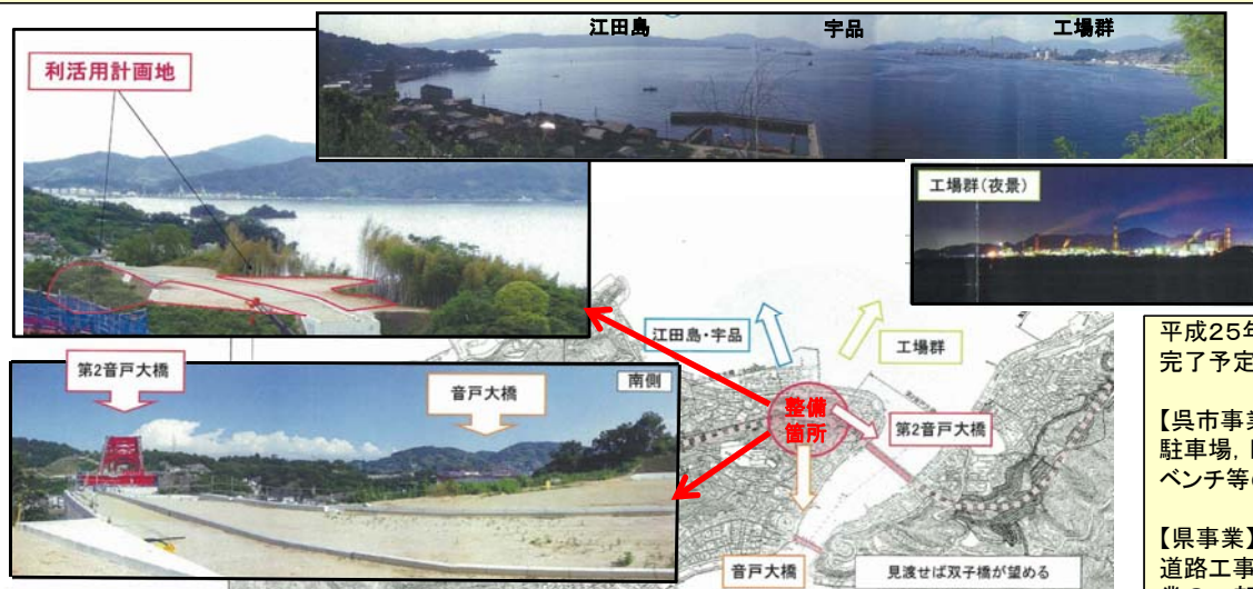
第2音戸大橋(仮称)音戸側広場利活用 計画地および広場からの眺望
