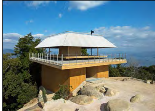
宮島弥山展望休憩所（平成25年11月完成）
