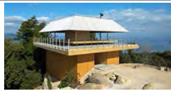
宮島弥山展望休憩所（平成25年11月完成）
