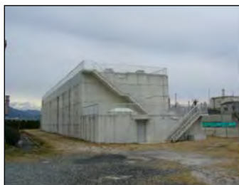
大竹処理区 雨水滞水池(完成)
