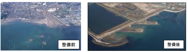
広島港五日市地区人工干潟の整備 (広島県)
