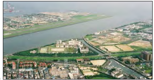
西部水資源再生センター (広島市:増設中)
