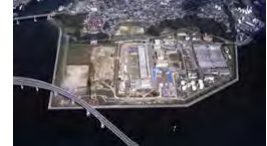
下水道における高度処理の推進 (太田川流域下水道東部浄化センター)
