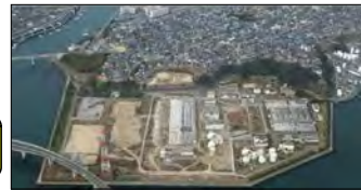
太田川流域下水道東部浄化センターにおける高度処理の導入推進（広島県）
