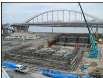
雨水滞水池(千田地区)の増設(広島市)
