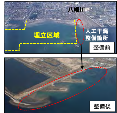
広島港五日市地区人工干潟の整備(広島県)
