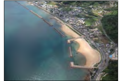
親水護岸の整備 (久賀港久賀地区)(山口県)
