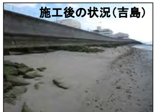
広島港海岸での高潮対策護岸整備にあわせた生物配慮型護岸の整備 (中国地方整備局)
