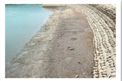
太田川底質改善箇所
