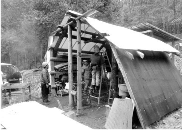
屋根の張替えが完了した小屋
