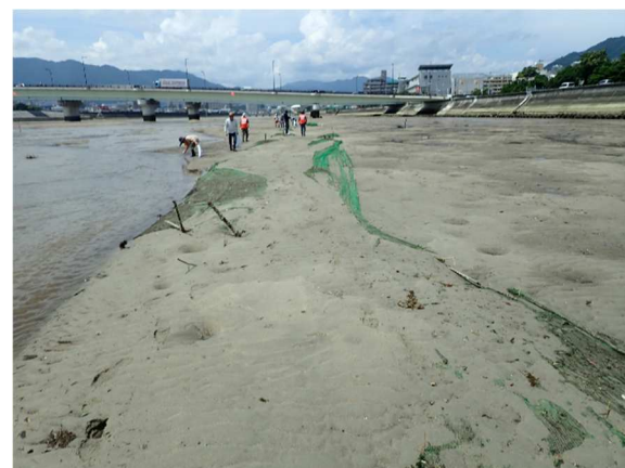
7月の出水で土砂に埋もれた食害防止ネット
