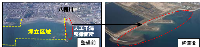
広島港五日市地区人工干潟の整備（広島県）
