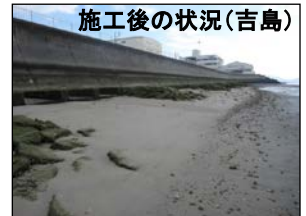
広島港海岸での高潮対策護岸整備にあわせた生物配慮型護岸の整備（中国地方整備局）
