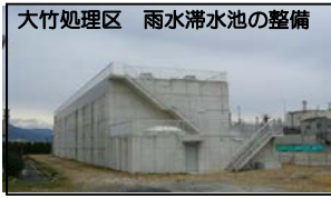
大竹処理区 雨水滞水池の整備 合流式下水道の改善 (H28年度末までに8地区改善予定)
