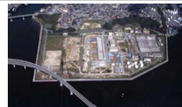
下水道における高度処理の推進 (太田川流域下水道東部浄化センター)
