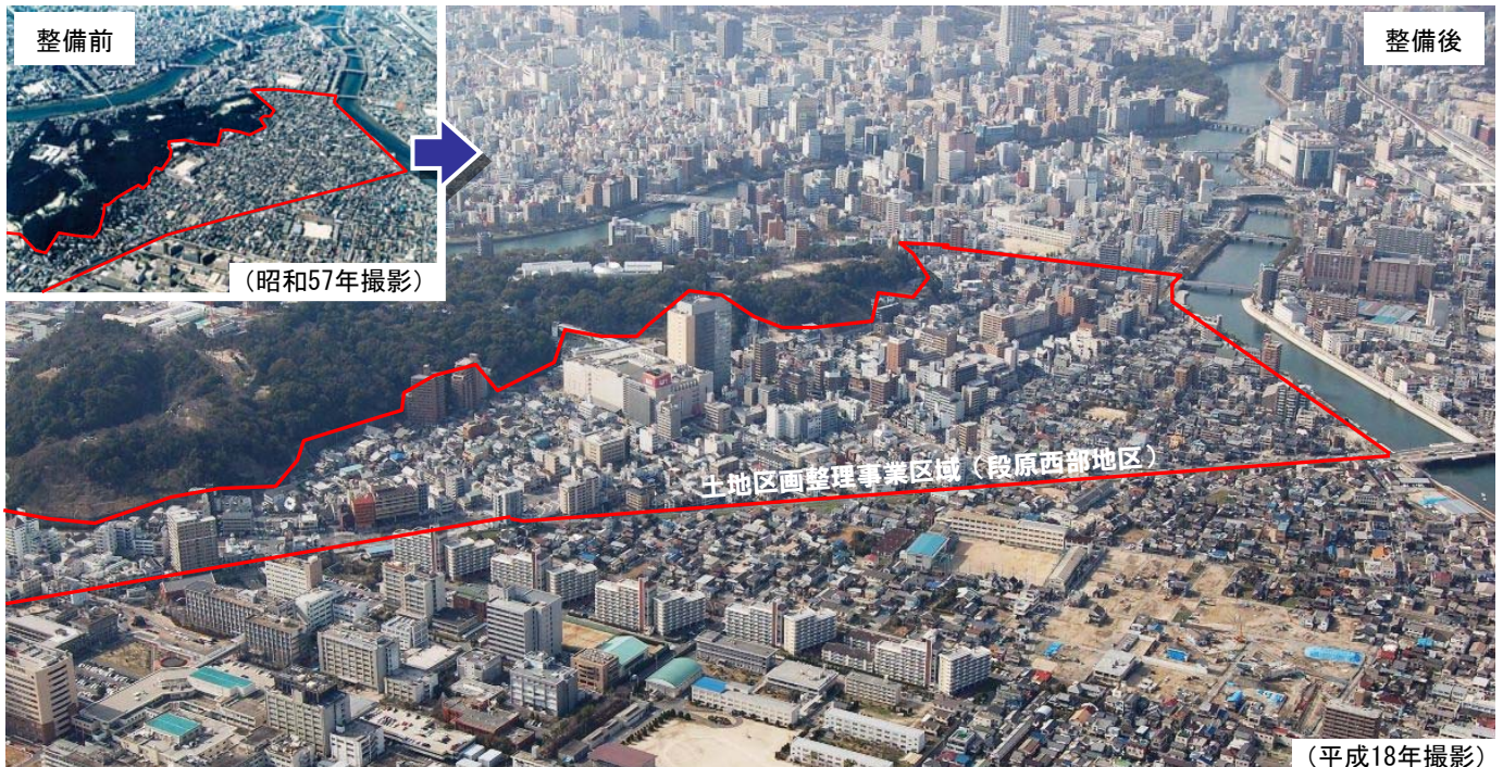
写真 土地区画整理事業区域全景
