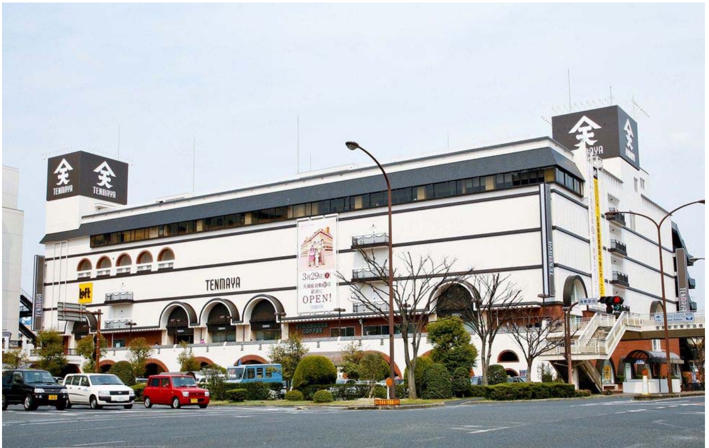
写真 再生した市街地再開発ビル
